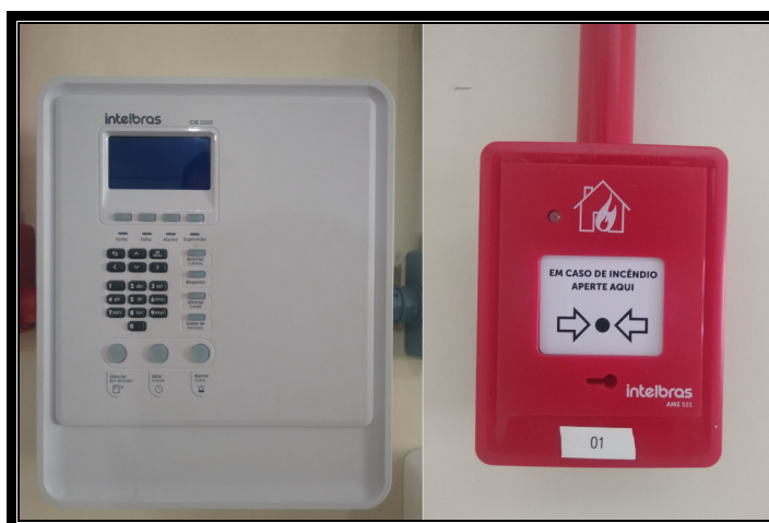
Central de Alarme Acionador de Alarme Fig. Central de alarme e acionador de alarme
